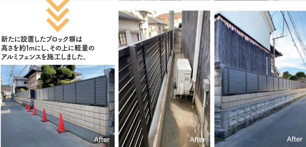
新たに設置したブロック塀は高さを約1mにし、その上に軽量のアルミフェンスを施工しました。
