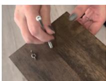
ラックの穴から突き出たボルトに蝶ナットを取り付けて固定します。板の継ぎ目を補強するためにアイアンウォールバーをはめ込んだら…
