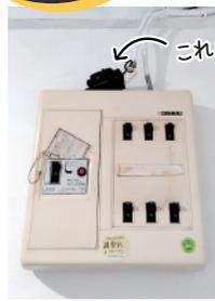
以前からフタが無く丸見えのブレーカーと、その上に乗ったエアコン用に増設した回路が気になっていたため、DIYでカバー作りにチャレンジしてみました。
