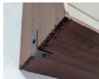
箱型に組んでボンドで接着したら、L字金具で補強します。
