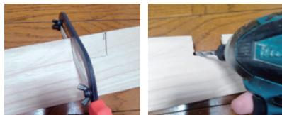
穴のサイズに、のこぎりで左右の切り込みを入れてから、電動ドリルで少しずつ穴を開けて繋いでいくと簡単に板が折れます。
