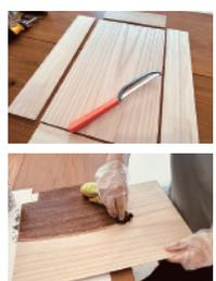
配電盤のサイズに合わせて板をカットし、オイルステインを布に浸して薄く塗り広げます。今回は表の見える部分のみ塗装しました。
